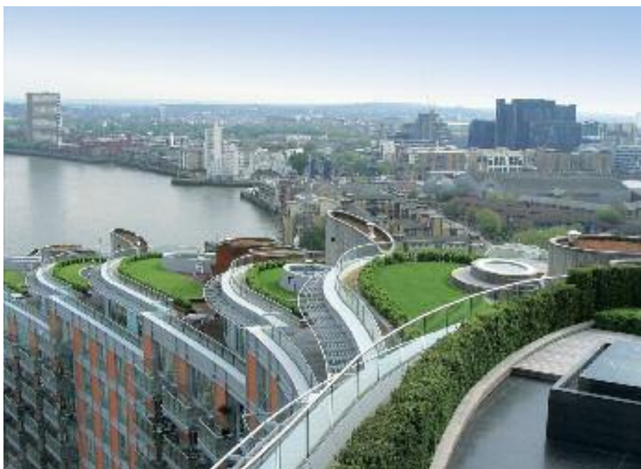
Bei Dachbegrünungen – hier ein Beispiel aus London – greift nach Auffassung der EU und eines deutschen Gerichts die CE-Kennzeichnungs-Pflicht von Dränelementen nicht.
