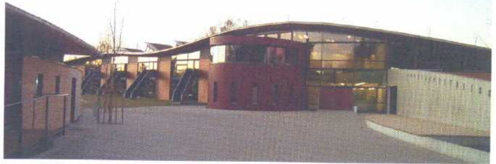
Schulgebäude mit Flachdach und installierter Leckmeldeanlage.
