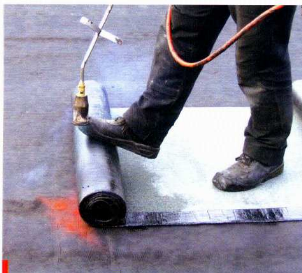
Alternatywa: ciepłowodociwne zgrzewanie warstwy kontaktowej z górną warstwą pokrycia
