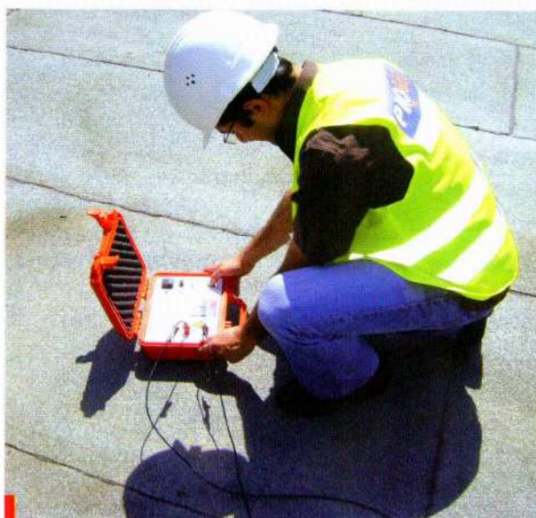
Nieskomplikowana kontrola szczelności za pomocą ręcznego aparatu
