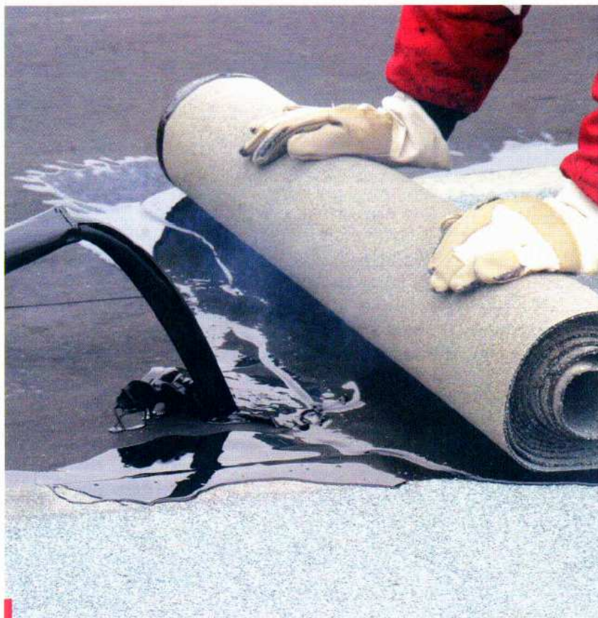
Całopowierzchniowe klejenie warstwy kontaktowej smartex® i górnej warstwy hydroizolacji
