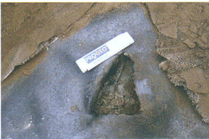
Präzise Ortung, selbst wenn die Leckage unter einer einen Meter dicken Erdschicht liegt
