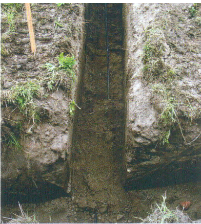
Deponie Tonnenmoor: Das Dichtungskontrollsystem wurde nachträglich in 80 cm tiefen Kabelgräben oberhalb der Abdichtung verlegt
