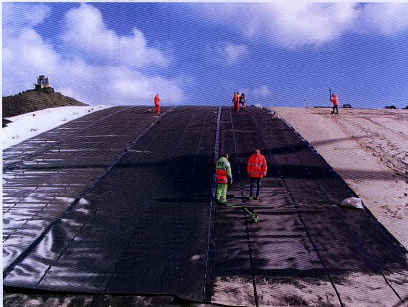
Im Böschungsbereich mit Neigungen von bis zu 1:3 lassen sich die Kabel ohne Probleme verlegen.
