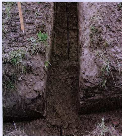
Auf der Deponie Tonnenmoor wurde das Abdichtungskontrollsystem nachträglich in 80 cm tiefen Kabelgräben verlegt.
