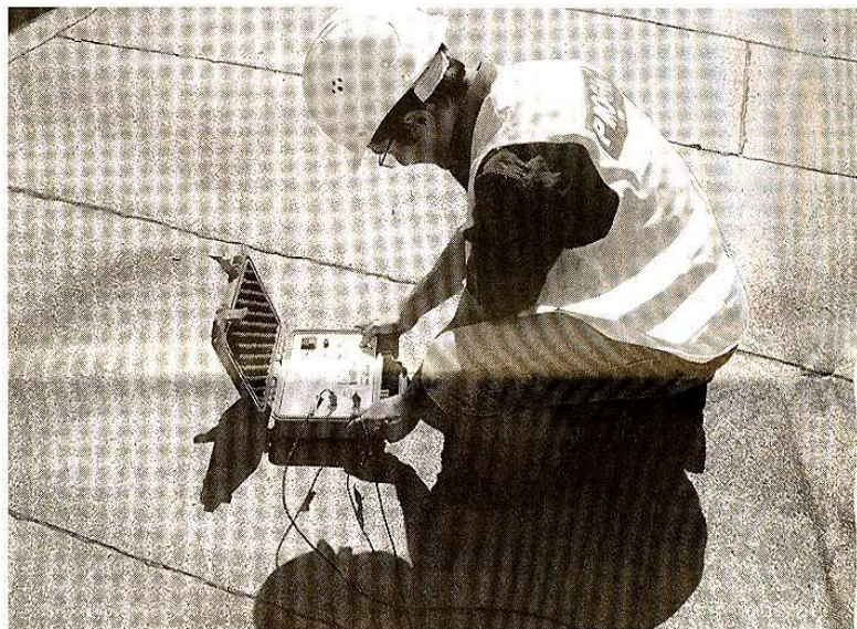
Facility-Management-Mitarbeiter des Krankenhauses können mit einem Handprüfgerät jederzeit überprüfen, ob das Dach dicht ist.
