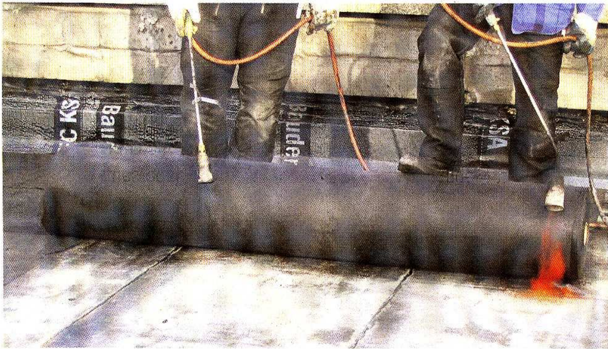
Einflämmen der elektrisch leitfähigen Kontaktlage.
