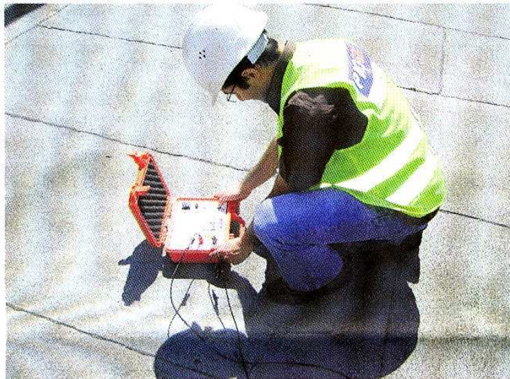
Dichtungskontrolle der Bitumenabdichtung mit dem Handprüfgerät.
