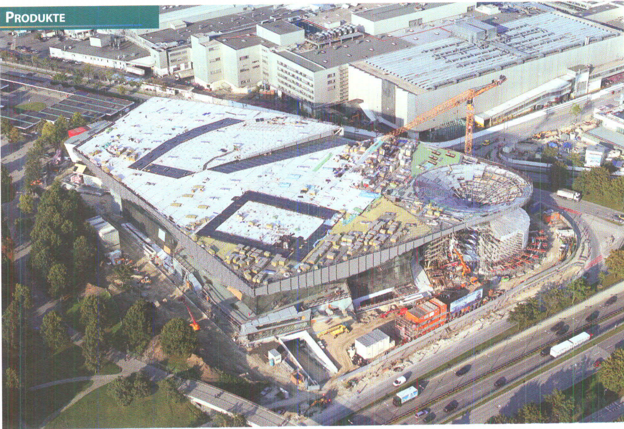
Blick vom Olympiaturm auf das 16.000 Quadratmeter große, von einer Leckmeldeanlage überwachte Flachdach der BMW-Welt in München.
