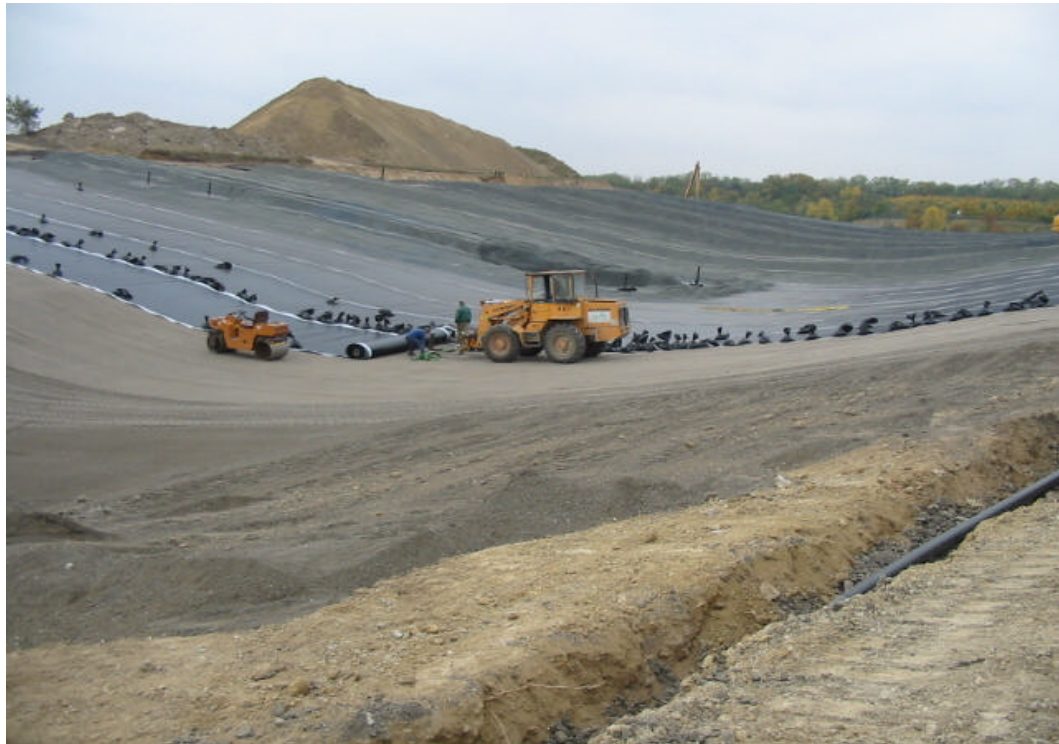
Abbildung 14 : Verlegung KDB und Einbau Flächenfilter im 1.Bauabschnitt (Oktober 2007)
