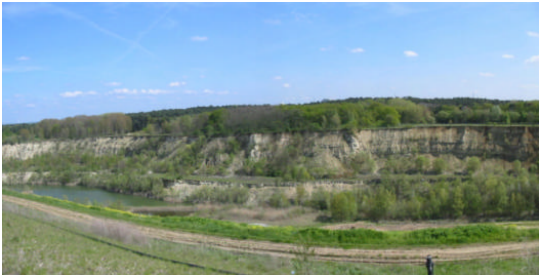
Abbildung 13: Blick vom Deponiekörper in Richtung Steilwand des Kalksteinbruchs
