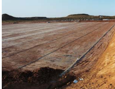
Verlegung der Komponenten im Messraster 5 x 5 m
